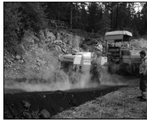
Асфальт Нагревательный кабель может засыпаться асфальтом при температуре не выше 160 °C.
